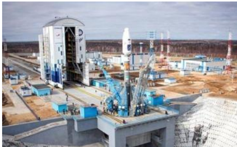
Рис. 5. Стартовый комплекс для РН «Союз» на космодроме «Восточный» с передвижной башней обслуживания
