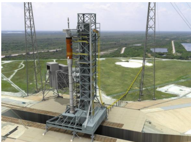
Рис. 7. Рельсовая система эвакуации космонавтов и обслуживающего персонала
