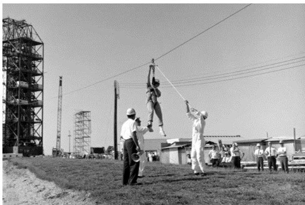
Рис. 6. Тросовая система эвакуации космонавтов и обслуживающего персонала
