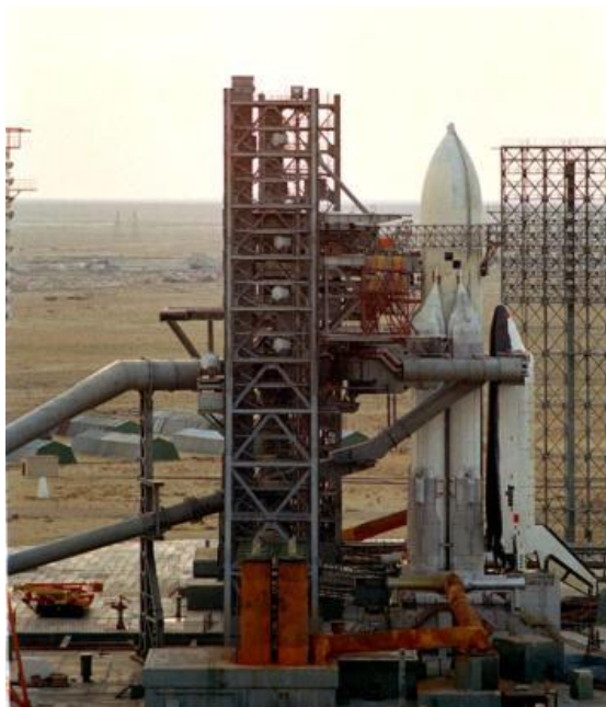
Рис. 3. Агрегат экстренной эвакуации экипажа и обслуживающего персонала корабля «Буран» (вид с боковой стороны корабля)
