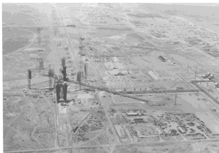
Рис. 4. Агрегат экстренной эвакуации экипажа и обслуживающего персонала корабля «Буран» (общий вид)
